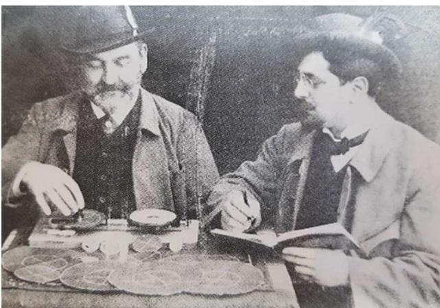
Carl Salch (links) und Malzfabrikant Erlanger mit der von Salch konstruierten ersten Mikrometerpunktmessmaschine
